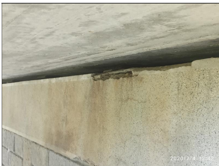
06. Degradace betonu opěry vlevo.jpg
