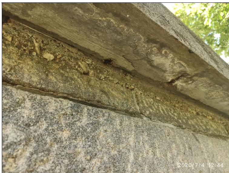
13.Vápenné výluhy a degradace betonu na římse vpravo.jpg
