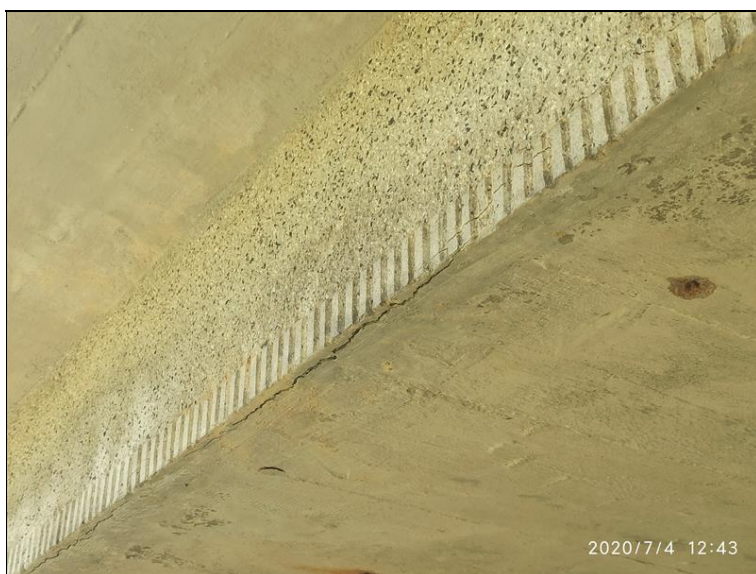
12.Trhliny na nosné konstrukci.jpg
