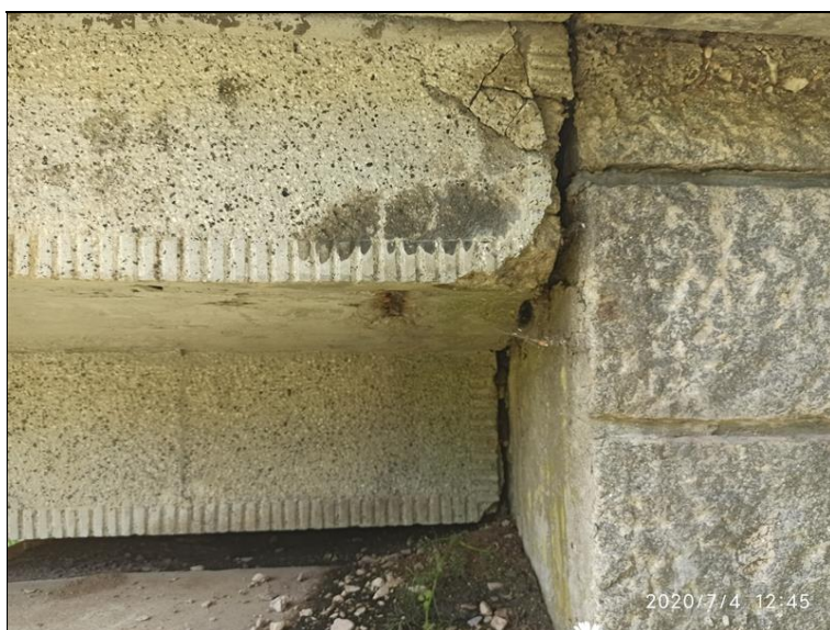
15.Degradace betonu nosné konstrukce.jpg
