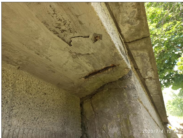
11.Degradace betonu na krajích nosné konstrukce.jpg
