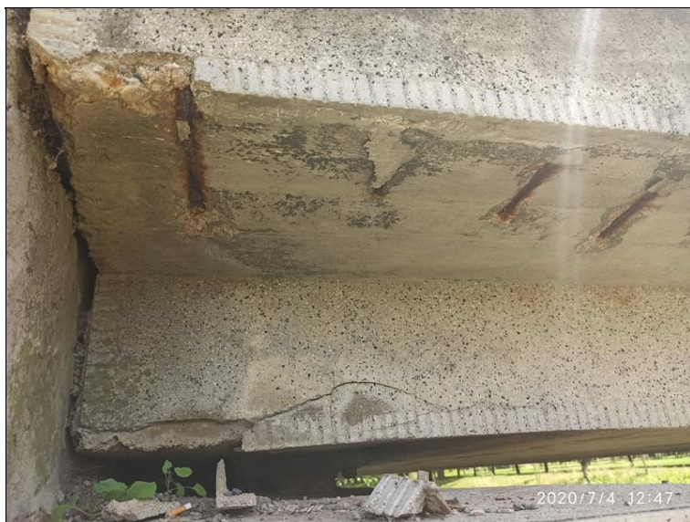
16.Degradace betonu a prorýsovaná výztuž NK vlevo.jpg
