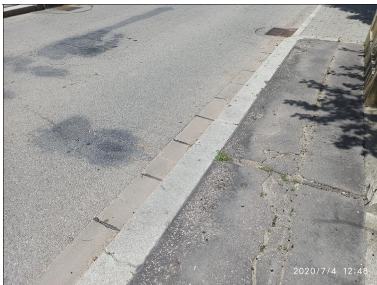
20.Trhliny na chodníku a vozovce.jpg
