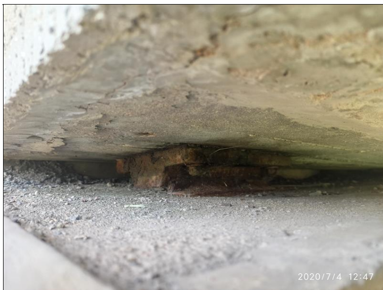
07.Zkorodované ložisko na opěře vlevo.jpg
