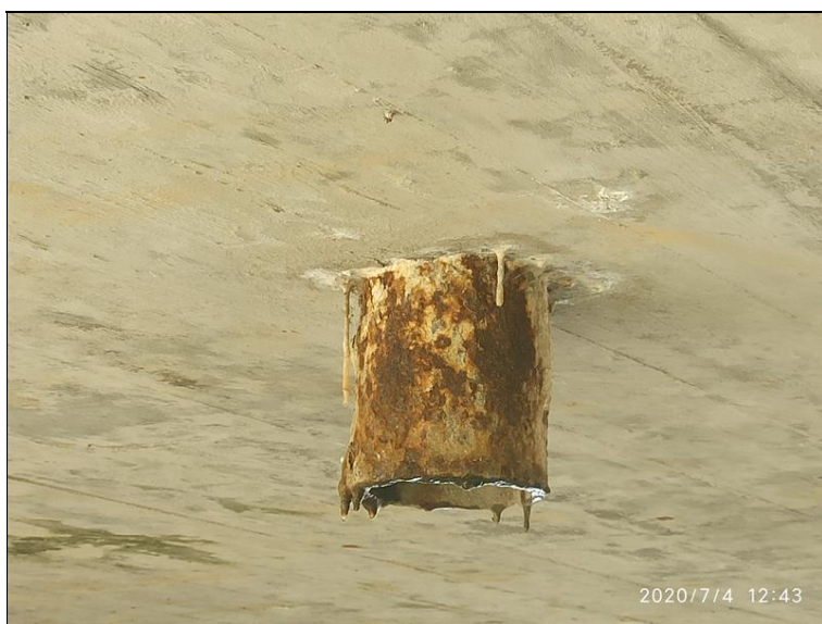
09.Krápníky kolem odvodňovače na nosné konstrukci.jpg
