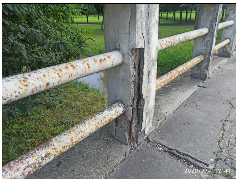
18.Koroze zábradlí a degradace sloupků.jpg
