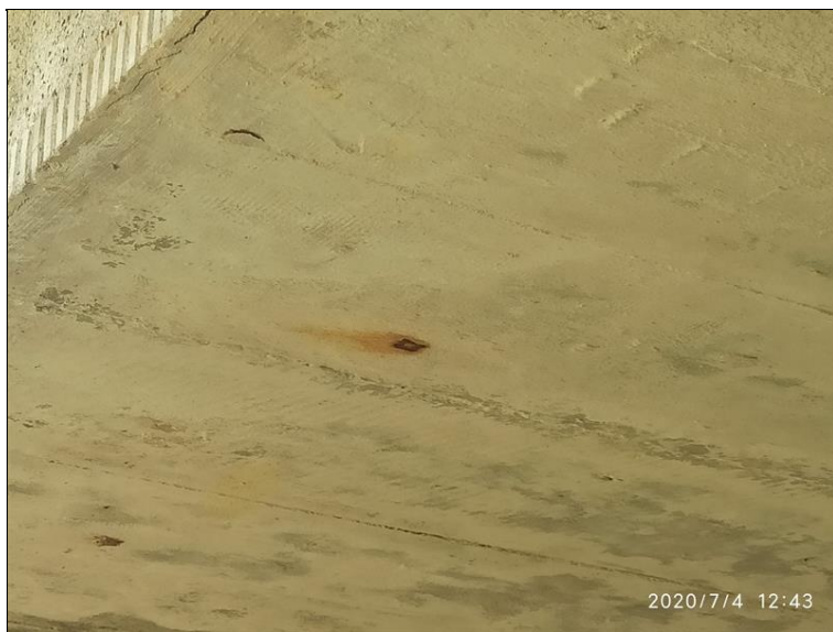
10.Prorýsovaná výztuž na nosné konstrukci.jpg
